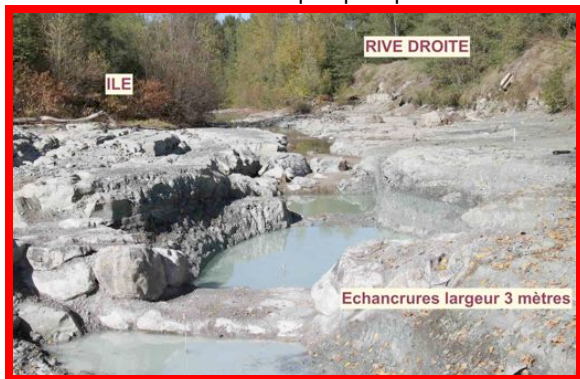
Bassins de la passe rive droite, hors d'eau
